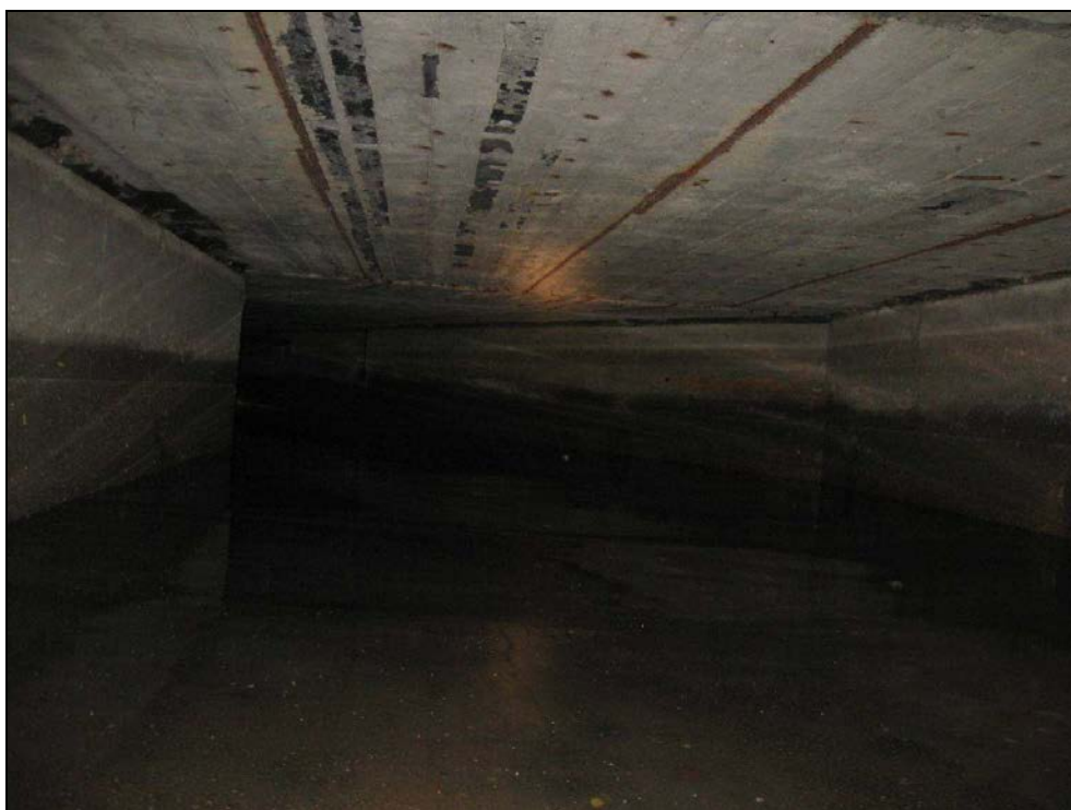
Obr. č. 5 - lom trasy objektu mezi pravou a střední částí. Beton nosné konstrukce je částečně místy opadaný a nosná výztuž místy obnažena. Podélné pruty obnažené v líci jsou distanční, ale tvoří dráhu pro vlhkost pronikající do nosné konstrukce
