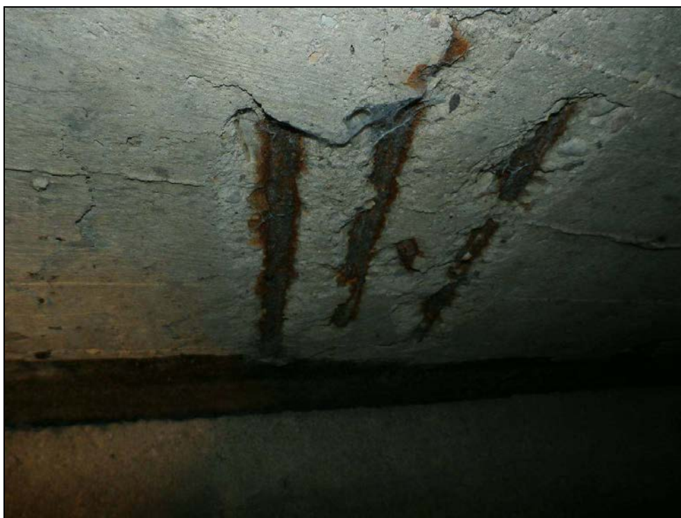
Obr. č. 12 - detail obnažené výztuže v NK ve střední části
