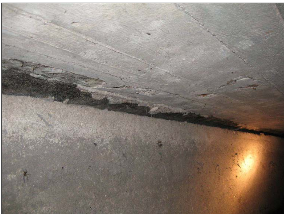
Obr. č. 7 - detailní pohled na spáru mezi NK a mostním prahem u opěry Praha ve střední části. Beton NK je místy opadaný, místy je v opadávkách obnažena výztuž.
