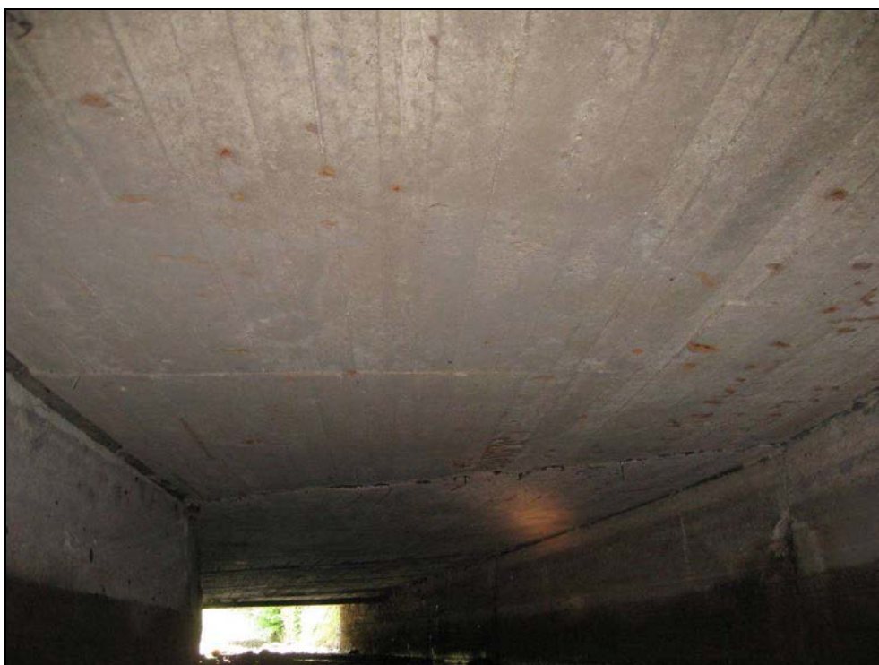
Obr. č. 11 - nosná konstrukce ve střední a levé části objektu. Stejný technický stav a skladba jako u pravé části.
