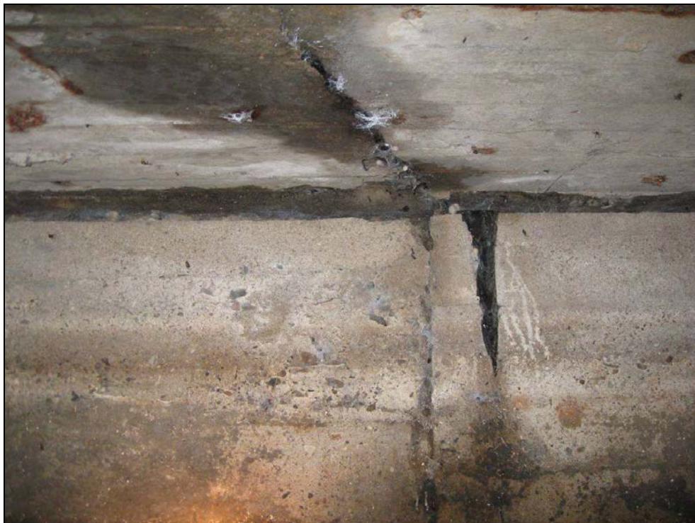
Obr. č. 10 - detailní pohled na dilatační (pracovní) spáru v NK a spodní stavbě ve střední části. Spárou prosakuje voda.
