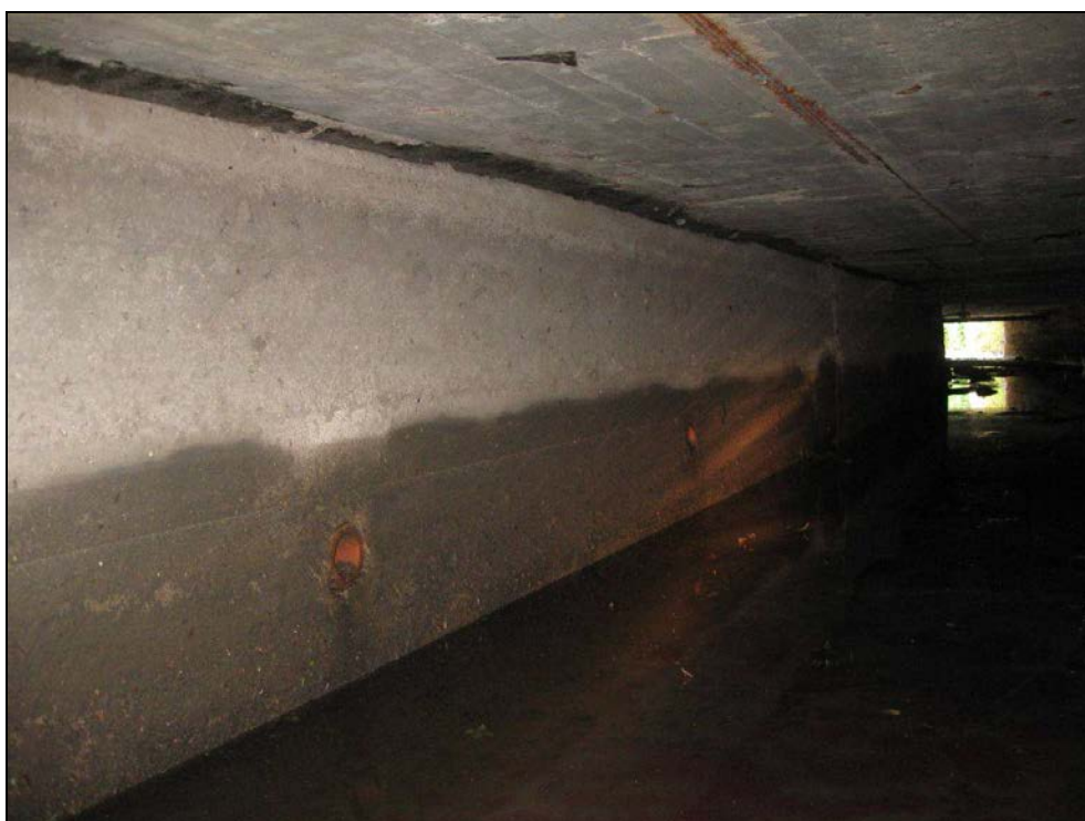
Obr. č. 6 - opěra Praha ve střední části. Stejná skladba materiálů (beton) ve stejném technickém stavu jako u pravé části.
